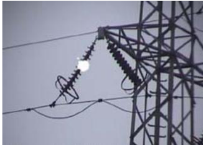
Figure A.28 – Isolation externe défailante – Exemple 1
