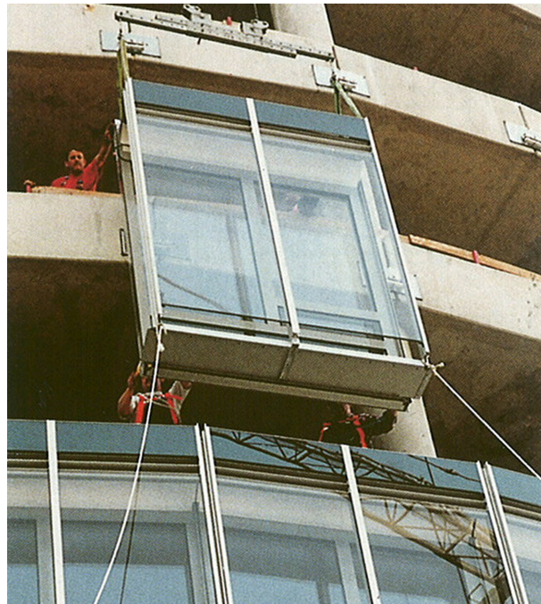
Bild B.1 — Foto einer Zweite-Haut-Fassade (Doppelfassade) Figure B.1 — Picture of double skin curtain walling Figure B.1 — Photo d'une façade rideau double peau
