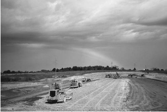
Fig. 2—Zonefill on an earthfill dam.
